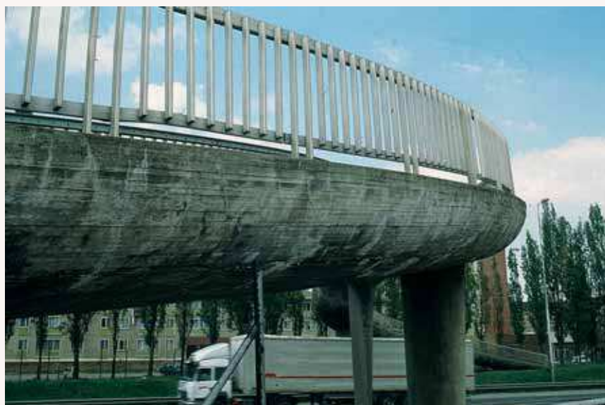
Fig. 12 – Vue générale de la passerelle
