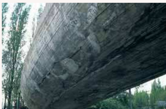
Vue de l'état avant.
