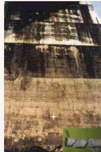
Fig. 5 – Vue de la pile.
