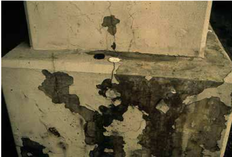
Fig. 5 – Fissuration d’une pile de pont revêtue d’une peinture et décollement de la peinture.
