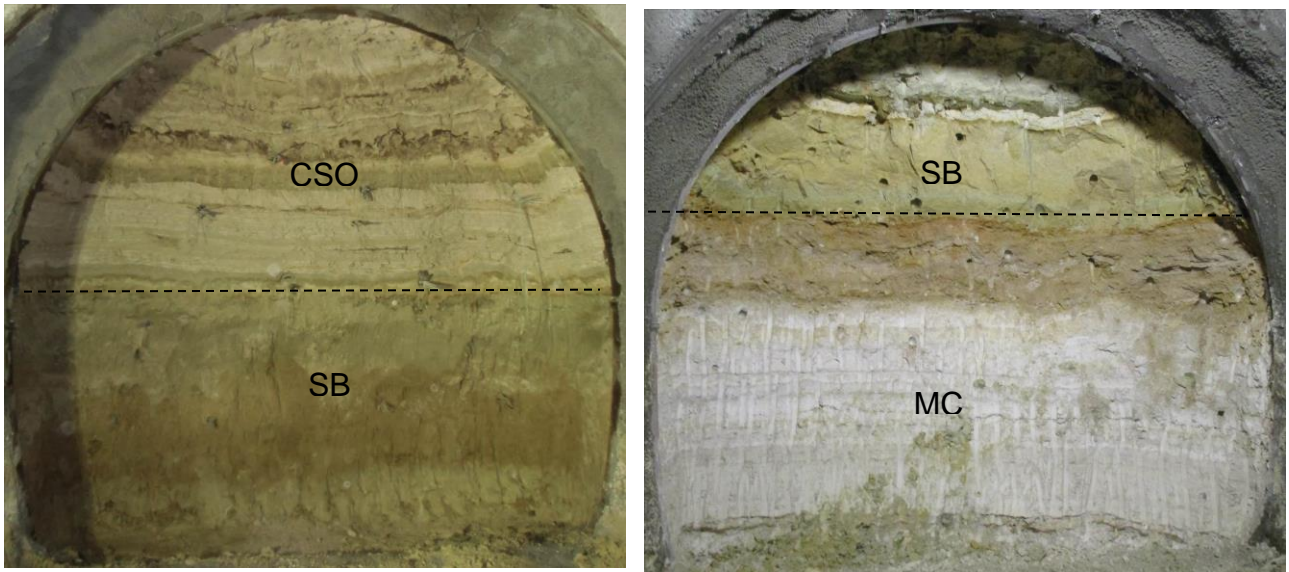
Figure 4. Diversité géologique des fronts de la galerie Stalingrad. CSO : Calcaire de Saint Ouen – SB : Sable de Beauchamp – MC : Marnes et Caillasses
