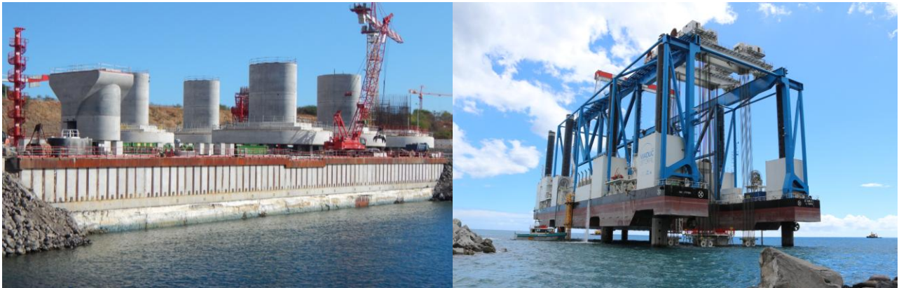
Figure 6. Préfabrication et pose en mer des semelles de fondation et barge Zourite
