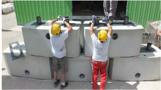
Figure 5. Blocs préfabriqués en béton avec réservations verticales de différents diamètres et renforcés par des armatures métalliques
