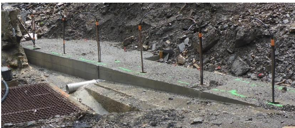
Figure 6. Vue sur la semelle en béton et les crayons d'ancrage en attente
