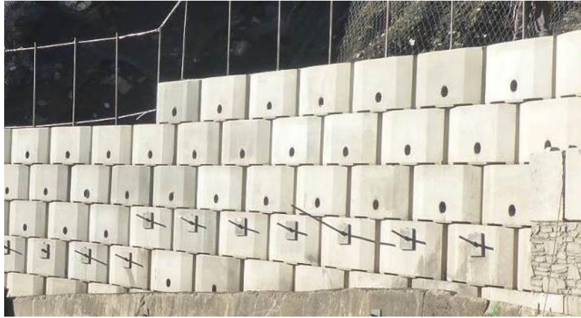
Figure 8. Vue sur l'ouvrage avec les barres inclinées
