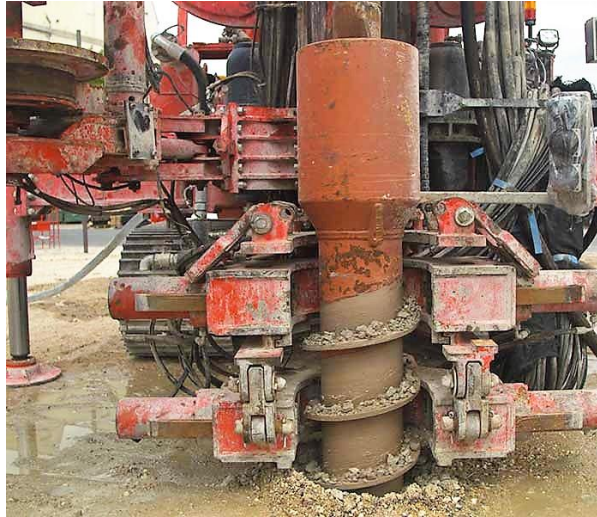
Figure 2. Virole à moitié vissée
