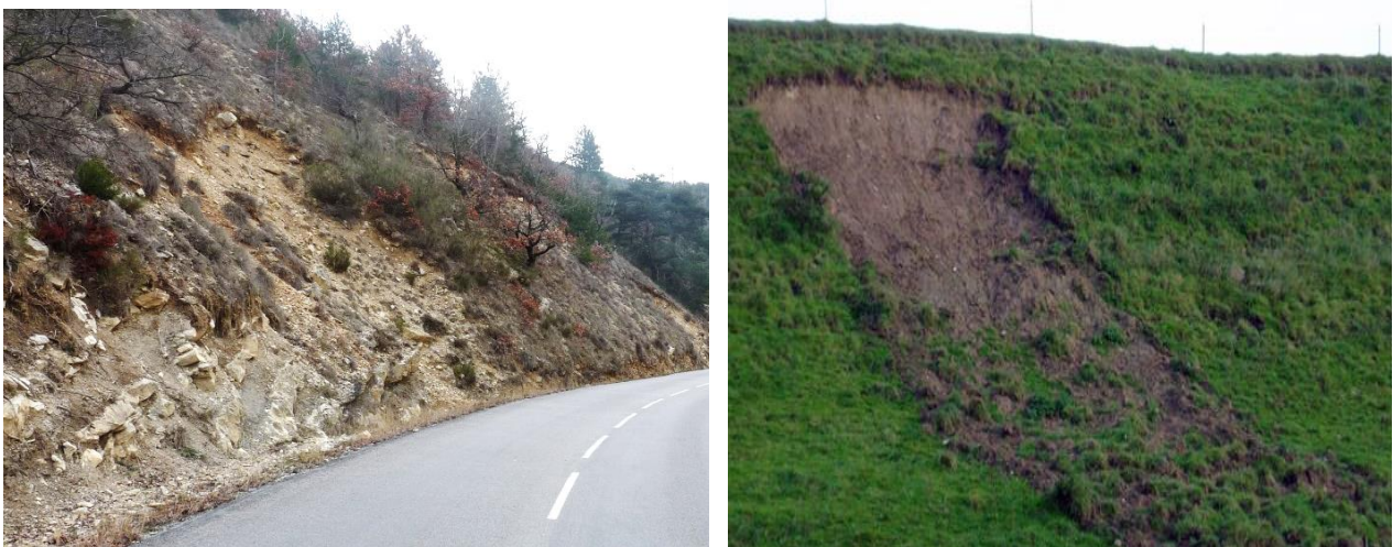
Figure n°1 : Exemple de talus affectés de désordres superficiels
