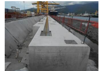
Figure 10. Réservations disposées sur un plot de la poutre de couronnement
