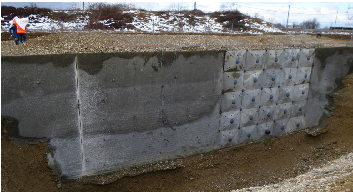
Figure 1. Ouvrage expérimental de Bévenais après creusement de la tranchée en pied
