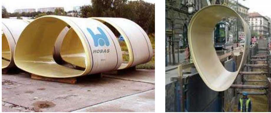
Figure 1 : Géométrie des coques PRV Arches (à gauche) et Ovoïde (à droite)
