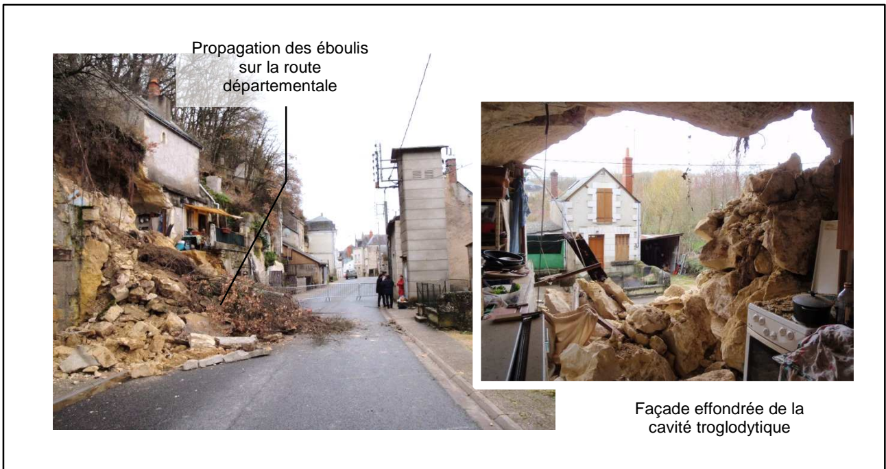
Figure 2 : propagation des éboulis sur la rue des Marches
