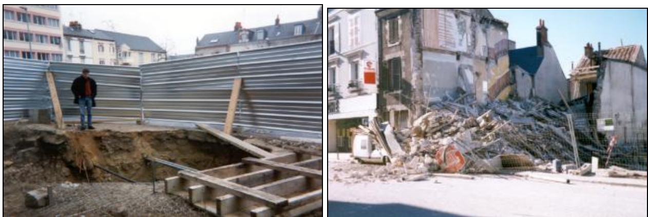
Fontis (diamètre 6 m, profondeur 11 m) Effondrement d'une maison Figure 4 : Désordres liés à des effondrements de cavités souterraines (photographies DEPR)
