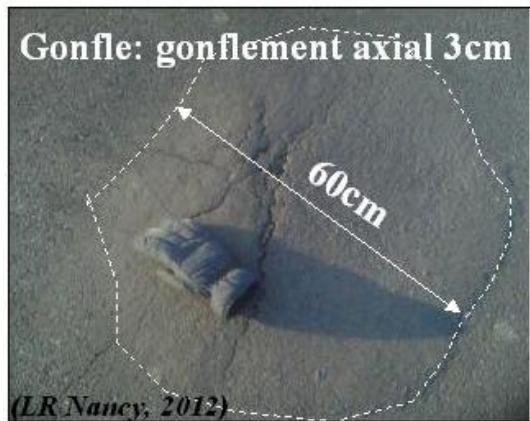
Figure 2: exemples de désordres dus à des gonflements de LAC.
