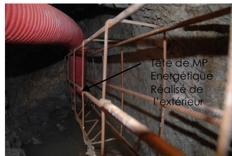
Figure 8. Sortie de la sonde en extrémité de la longrine de liaison en sous-œuvre (photo auteur).
