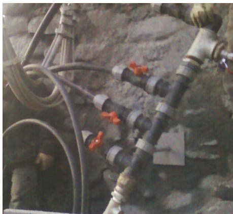
Figure 9. Test de mise en charge avant injection (photo auteur).
