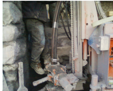
Figure 6. Descente des sondes dans l'armature (photo auteur).
