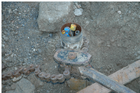
Figure 7. Sondes et tuyau d'injection dans micropieu (photo auteur).
