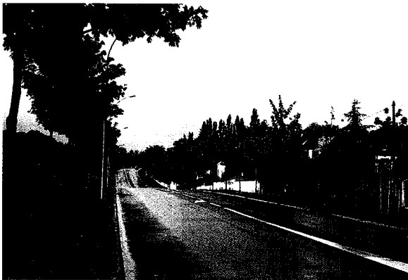
Fig. 2 - Vue de la chaussée inspectée du Mans.
