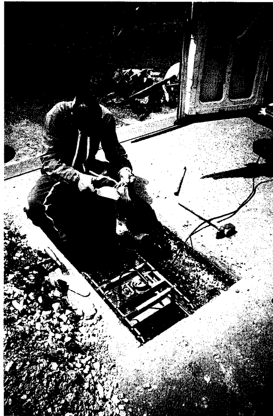
Fig. 3. - Mesure de la densité en place au gammadensimètre.
