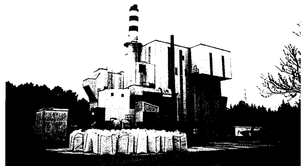
Fig. 1 - Vue de l'usine d'incinération de La Teste et de la chaussée inspectée.
