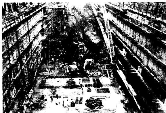
Fig. 8 - Paroi berlinoise réalisée pour la construction de l'ensemble Maine-Montparnasse (d'après Fenoux, 1971, p. 22).
