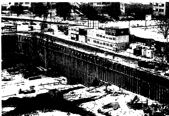
Fig. 7 - Soutènement d'une excavation par un écran de palplanches.
