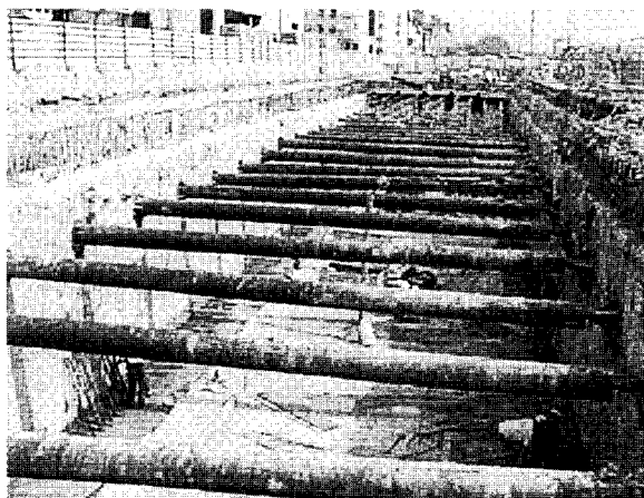
Fig. 15 - Butonnage d'une tranchée couverte en phase provisoire.
