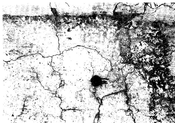
Fig. 1b - Fissuration multidirectionnelle du mur culée.
