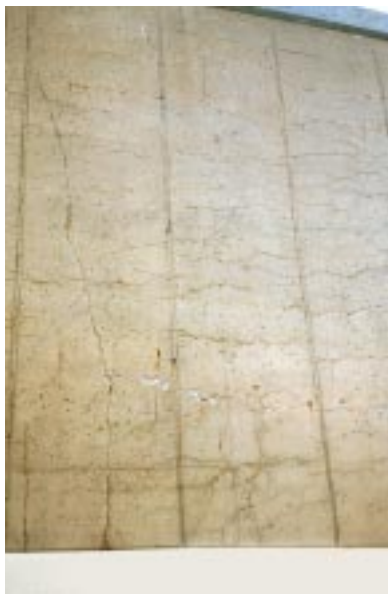
Fig. 2 - Mur de la tranchée couverte Samson.
