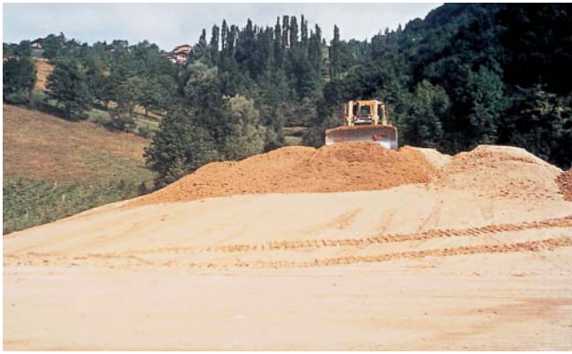
Fig. 9 - Mise en stock des matériaux criblés par couche de 80 cm d'épaisseur.
