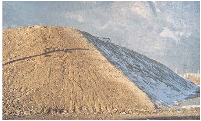
Fig. 10 - Stockage provisoire des matériaux criblés.
