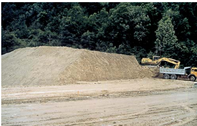
Fig. 12 - Reprise frontale « en rétro » des matériaux.
