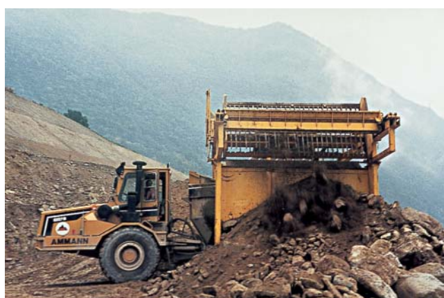
Fig. 8 - Basculement vertical de la grille.
