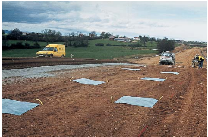
Fig. 2 - Mise en place et repérage des bâches.
