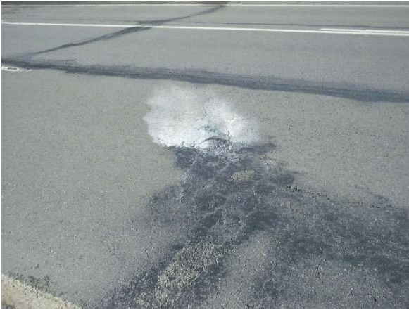
Fig. 7 - Vue du revêtement d'un pont autoroutier. De fines particules de ciment sont visibles. Elles proviennent du béton du tablier qui se dégrade et remontent au travers du revêtement asphaltique.
