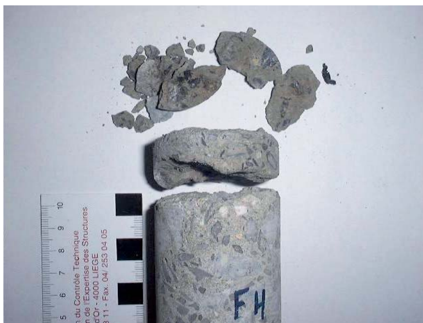
Fig. 5 - Carotte Ø 50 mm prélevée dans un tablier d'un pont autoroutier. La délamination du béton, ainsi que sa désagrégation sont visibles en partie supérieure de la carotte.
