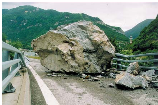
Fig. 1 - Chute de bloc à Moûtiers (Savoie). (Photo communiquée par Jean-Armand Calgario, SETRA).
