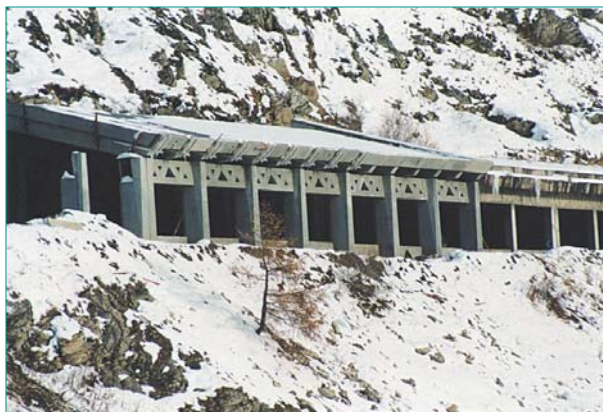
Fig. 5 - Paravalanche du Chevril (Savoie) en fin de construction.
