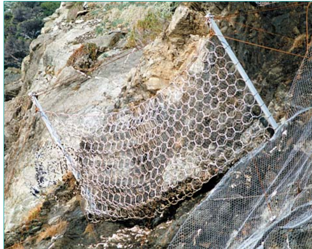
Fig. 2 - Écran déformable de type filet anti-sous-marin au Cap Sicié (Var).
