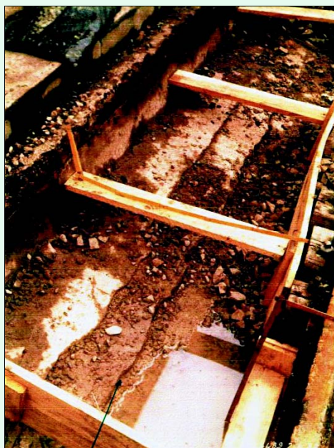
Fig. 16 - Rupture et tassement du radier par fissuration longitudinale.
