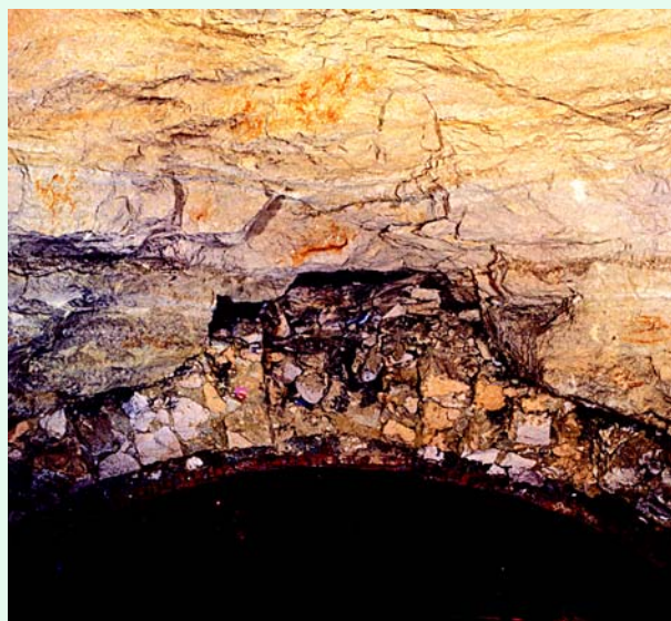
Fig. 1 - Surcreusement en clé de voûte dû à un mauvais positionnement de la galerie de faîte.
