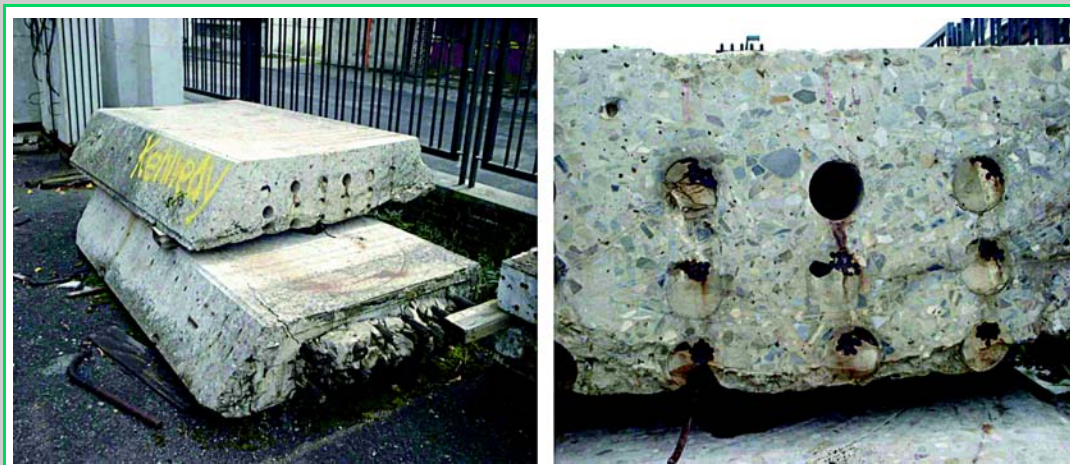
Fig. 8 - Vues du bloc d'about de tablier précontraint.
