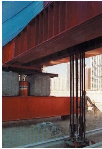
Fig. 3 - Essai de chargement statique d'un pieu.
