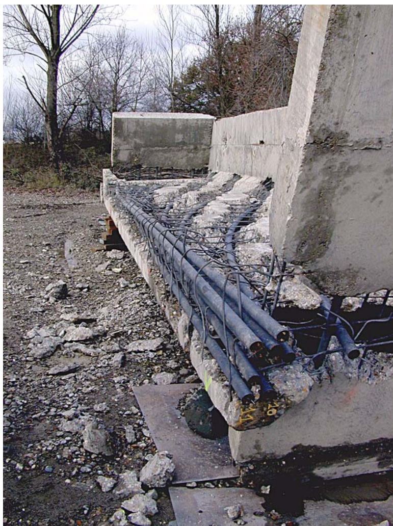
Fig. 8 - Armatures de la poutre test après hydro-démolition.
