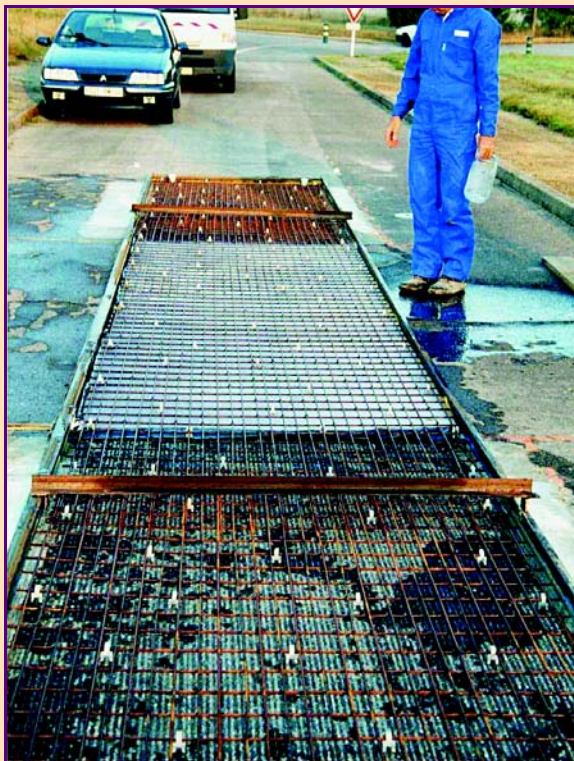
a) Vue du coffrage et du ferrailage.
