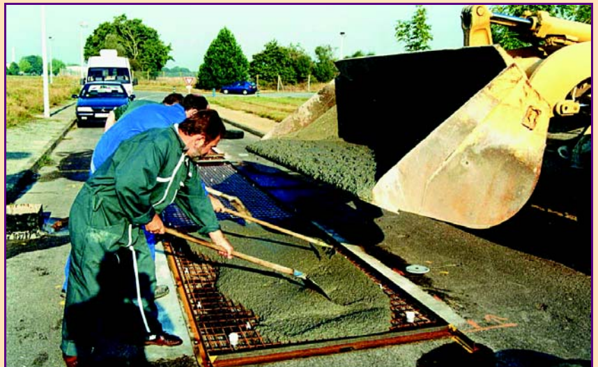
b) Coulage du béton.
