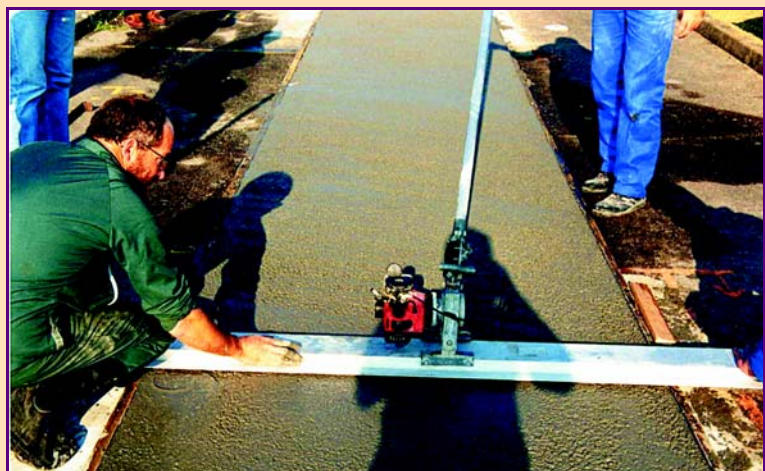
c) Finition à la règle vibrante.
