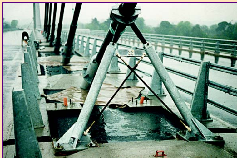
Fig. 9 - Exemple d'amortisseur au point bas d'un hauban.
