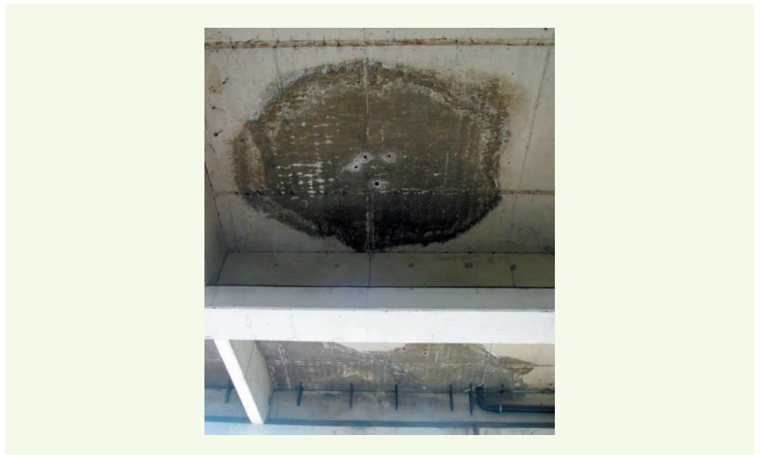
figure 1 Taches foncées en face inférieure d'un pont.
