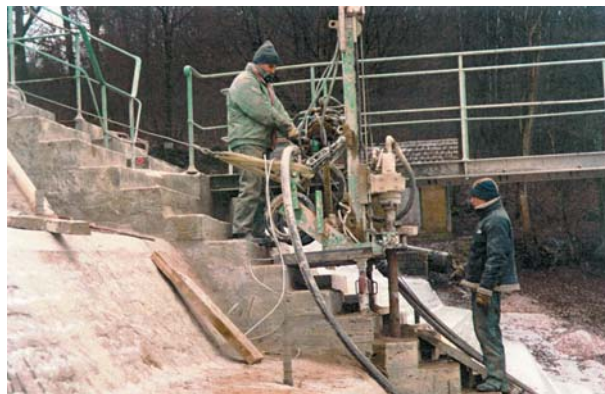
figure 13 Forage avant mise en place du tube d'injection.
