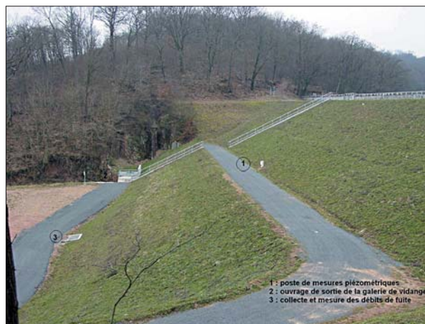
figure 18 Vue du talus aval après travaux.
