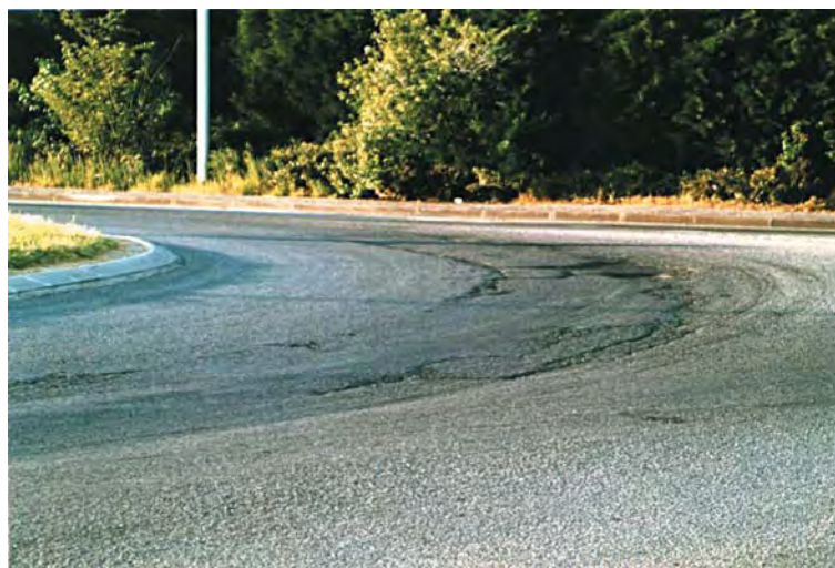
figure 1 Effets des efforts tangentiels dans les points singuliers : a) arrachement dans un giratoire ; b) déplacement horizontal près d'un feu rouge.
