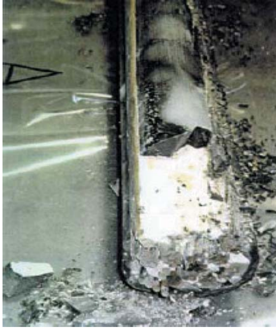
figure 1 Vue de l'intérieur d'un conduit après rupture d'un câble de précontrainte.
