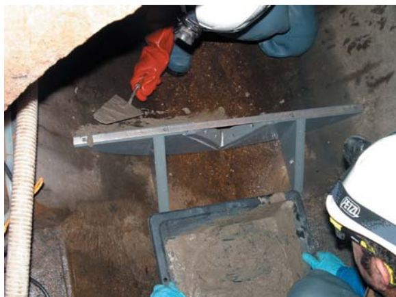
figure 6 Mise en place du seuil avec forme en V.
