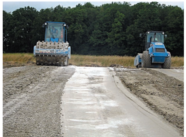
figure 9 Extraction et traitement au déblai.
