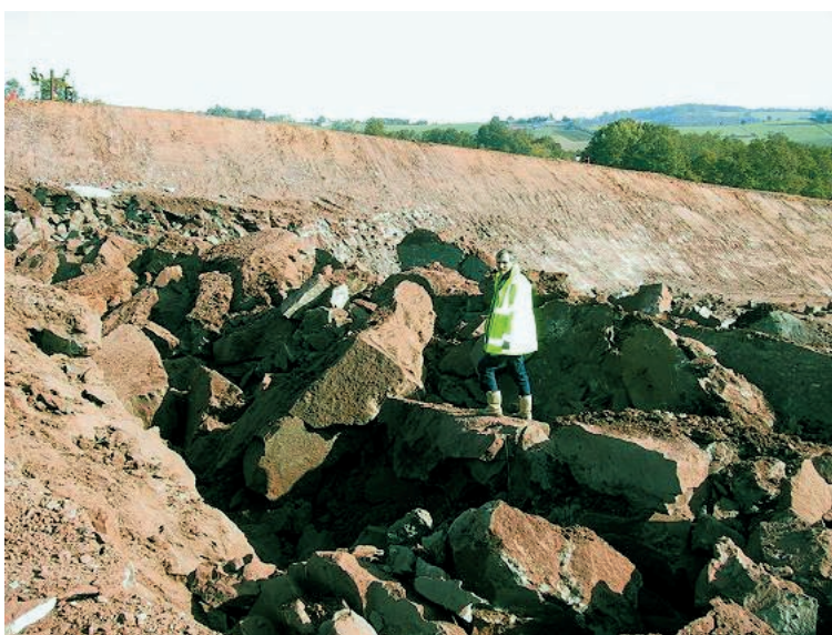
figure 6 Extraction des pélites par minage.
