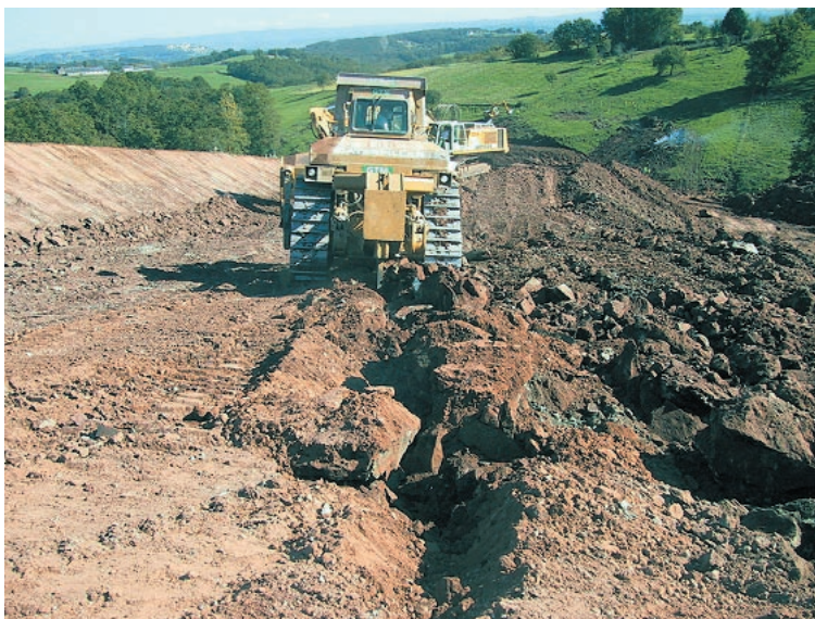
figure 5 Extraction des pélites indurées par rippage.
