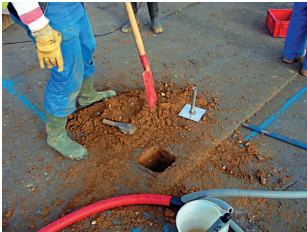
figure 16 Tassomètre – Excavation pour pose de la flasque inférieure.
