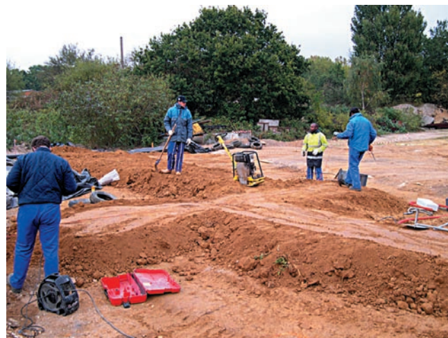
figure 7 Réalisation et instrumentation des lits de pose dans la base effondrable.
