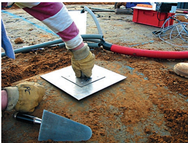
figure 17 Tassomètre – Pose de la flasque supérieure.
