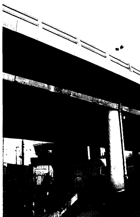
Fig. 2 - Zone et situation des clavages au ciment alumineux.
