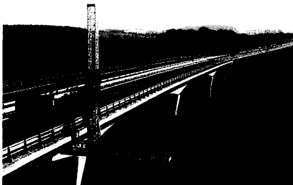
Fig. 1 - SCORPION sur le premier pont-caisson ausculté de façon opérationnelle en 1985.
