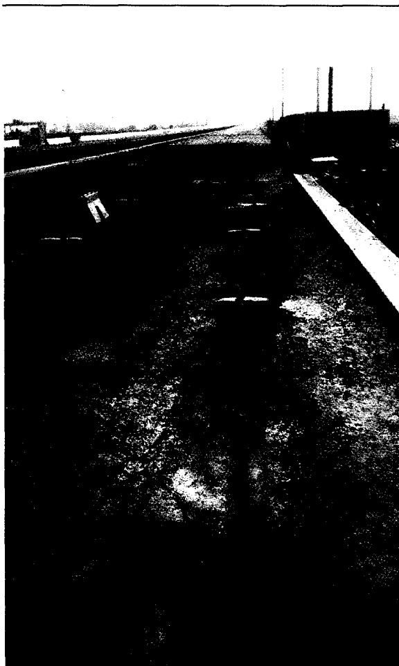
Fig. 7 - Gonflement sur autoroute suite à une réaction sulfatique.
