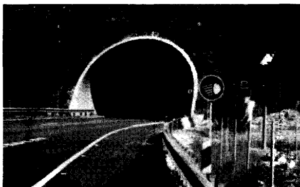
Fig. 6 - Contrôle d'accès à un tunnel au moyen d'un feu.
