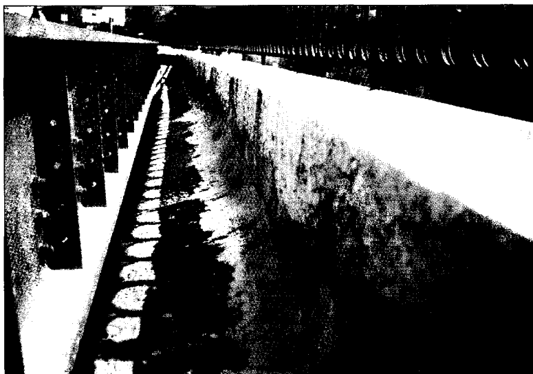
Fig. 3 - Décollement entre le couronnement et le corps de voûte.
