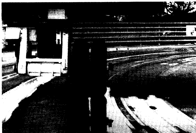
Fig. 14 - Ornièrre sous un jumelage type.
