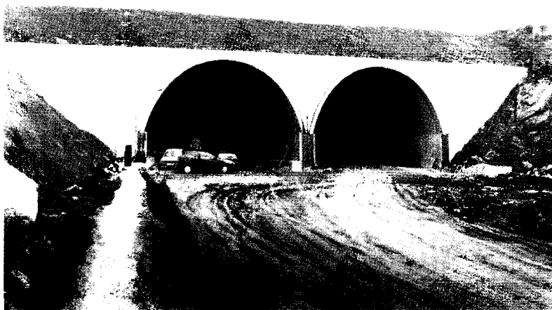
Fig. 2 - Tunnel de Guisamo-Mino, Galicia (Espagne), 1997. (Portée : 2 * 12,50 m - longueur : 2 * 250 mètres).
