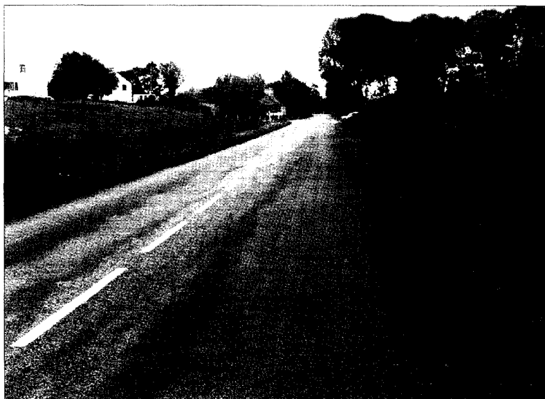
Vue de la chaussée après reprofilage.
