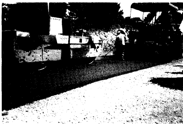
Atelier de mise en œuvre. Au premier plan, on peut observer la variation importante de l'épaisseur répandue.
