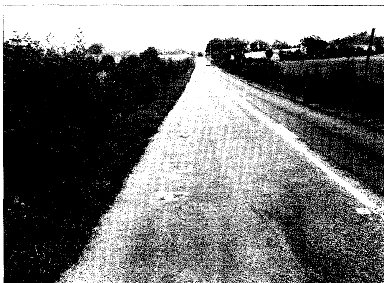
Dégradation sur la partie GNT 0/30 après travaux à un an.
