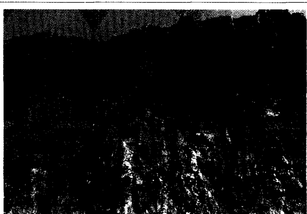
Fig. 5 - Talus découpé en cordeau détonant de 70 g. Les erreurs d'implantation de forage sont dues à une mauvaise plate-forme de départ.
