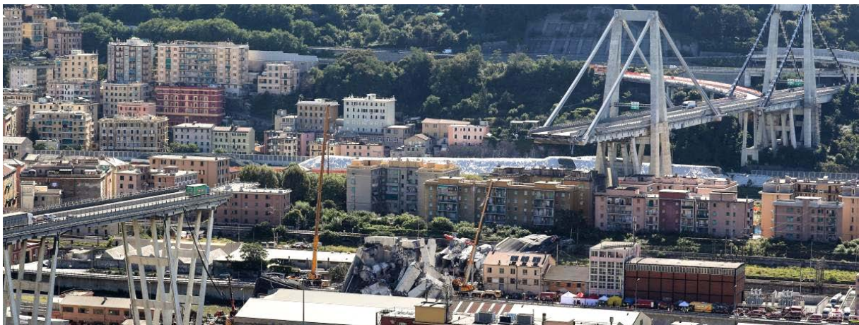
Effondrement d'une partie du pont Morandi à Gênes (Photo AFP – Valery Haché)
