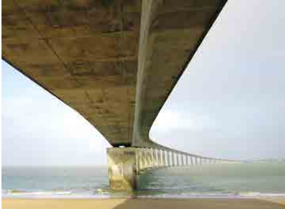
Pont de l'île de Ré
