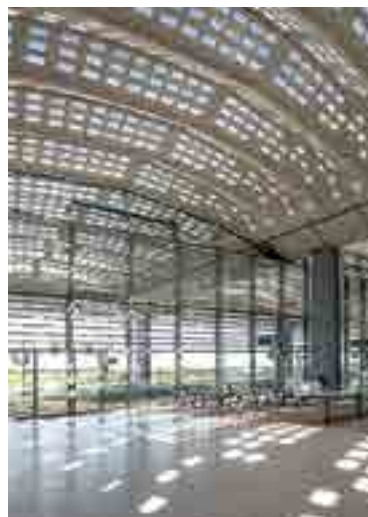
Couverture en BFUP incrusté de pavés de verre de la nouvelle gare TGV de Montpellier Sud-de-France
