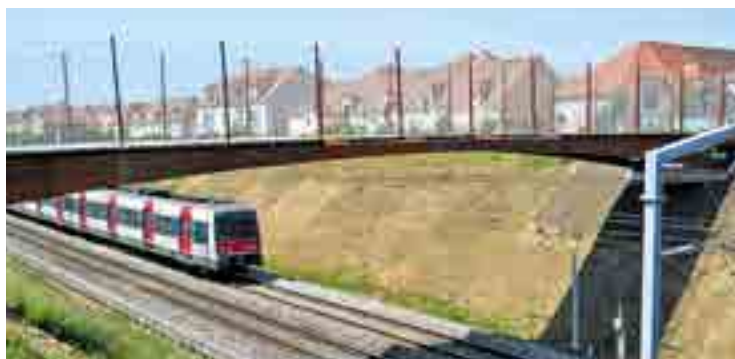
Passerelle de Bussy Saint-Georges en acier autopatinable (laboratoire Structures métalliques et à câbles)
