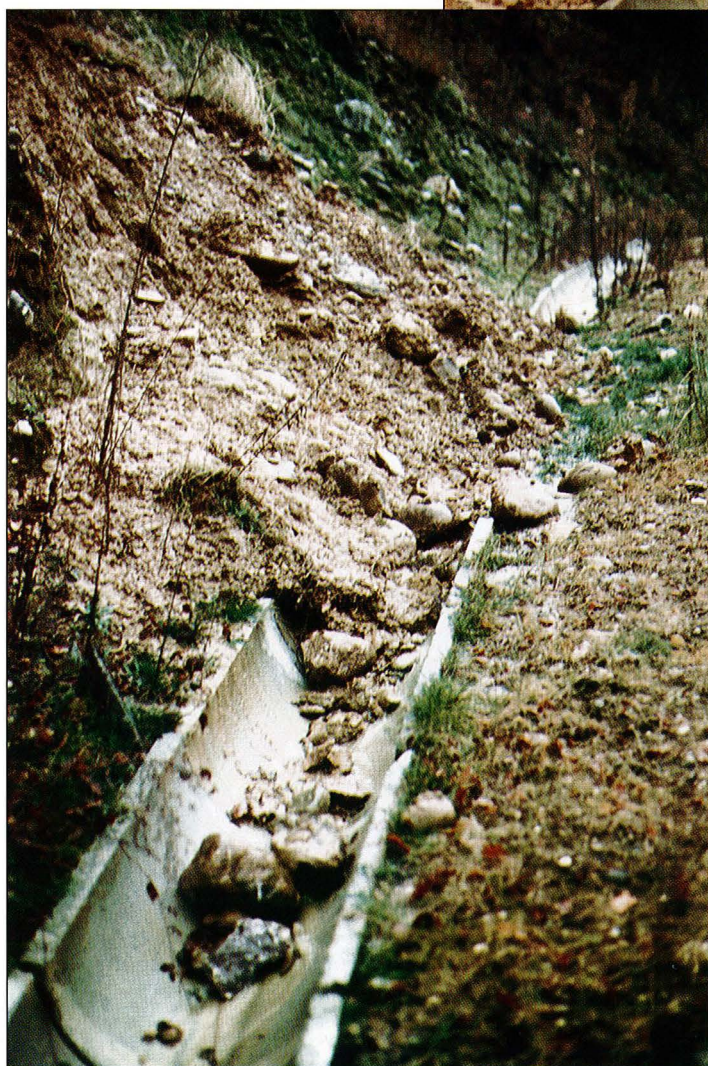
Photo n° 38 : Les fils d'eau doivent être entretenus pour éviter le débordement des eaux sur des terrains non préparés.
