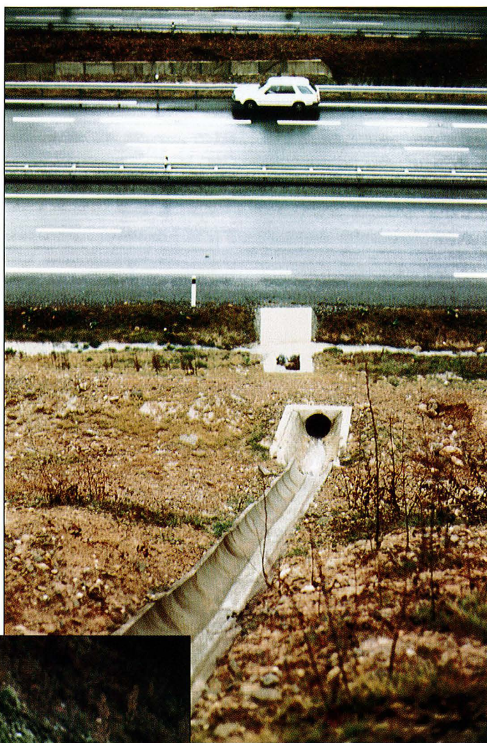
Photo n° 37 : La descente d'eau provenant d'un fil d'eau sur risberme (photo n° 24, page 58) arrive ici dans un exutoire bétonné installé sur une risberme de niveau inférieur. La descente des eaux continue ensuite par un tuyau enterré vers le fossé de l'accotement autoroutier.
