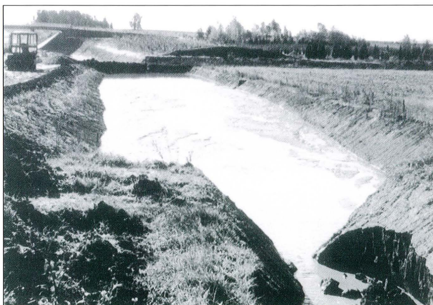
Photo n° 4 : Large bassin provisoire de sédimentation à l'aval d'un chantier de terrassement. Il empêche une trop grande pollution des eaux courantes du voisinage.
