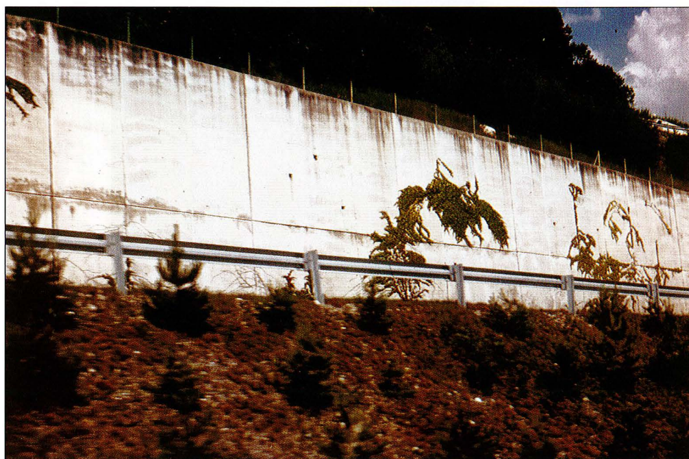
Photo n° 34 : Mur poids en béton. Une vigne vierge commence heureusement à le tapisser.
