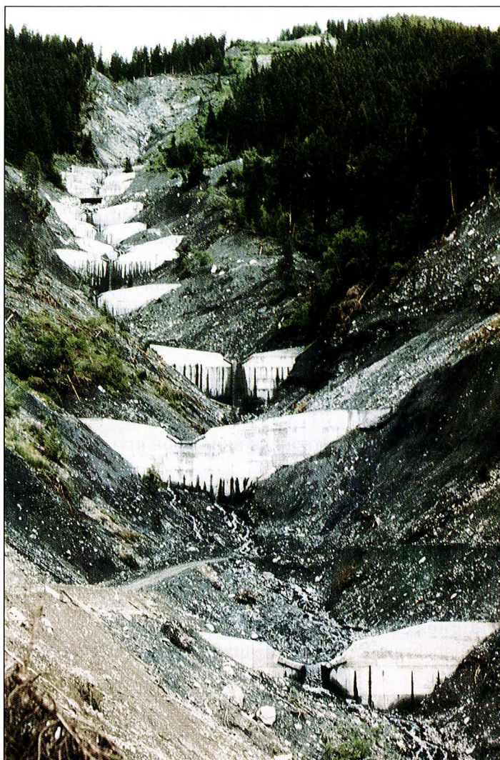
Photo n° 43 : Barrages de stabilisation de marnes noires dans le torrent de la Ravoire ( Savoie).
