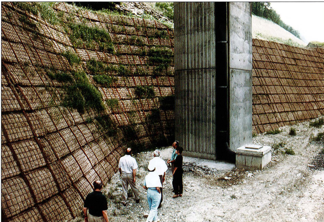
Photo n° 30 : Sous le tablier d'un pont, mur armé d'une grille avec paillis pour engazonnement.
