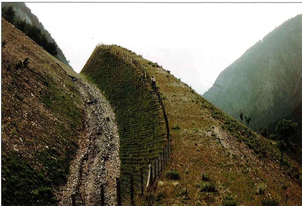
Photo n° 31 : Merlon de protection en pneusol.
