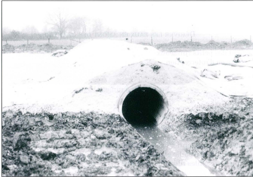
Photo n° 35 : Buse permettant le rétablissement d'un écoulement naturel sous un futur remblai.
