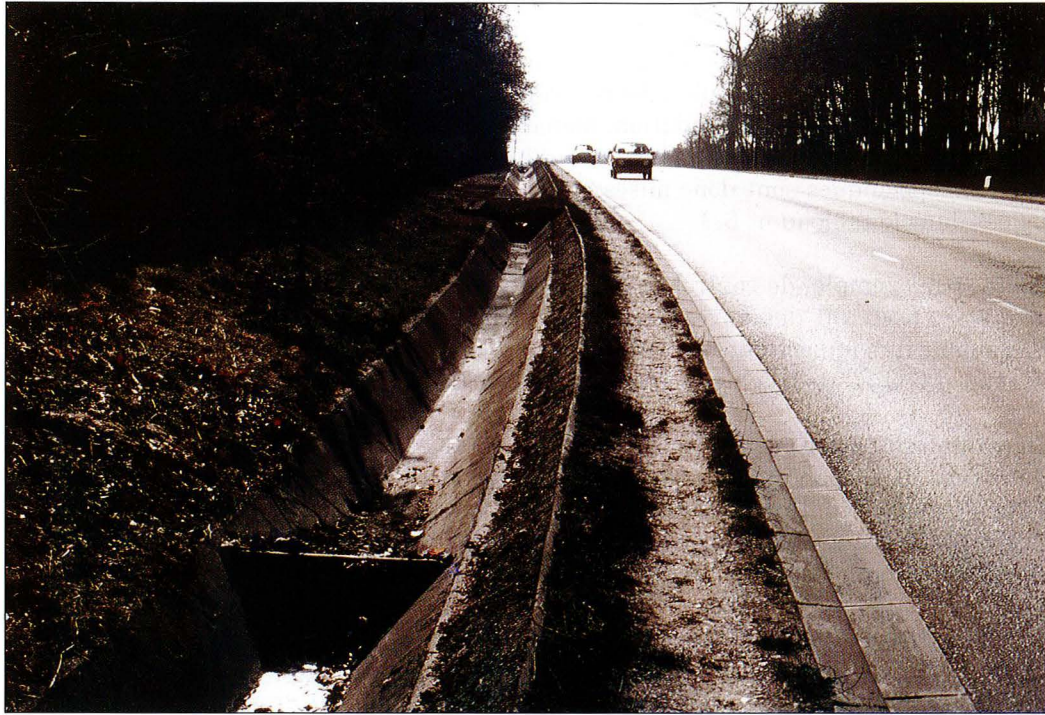
Photo n° 41 : Dans un fossé très pentu le bétonnage est conseillé. Remarquer au premier plan dans le fossé un petit déversoir pour briser l'énergie des eaux.
