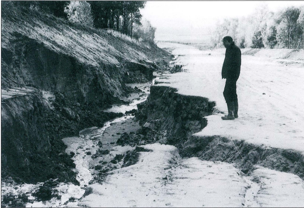
Photo n° 39 : Plateforme routière, en sable, ravinée après une pluie d'orage.
