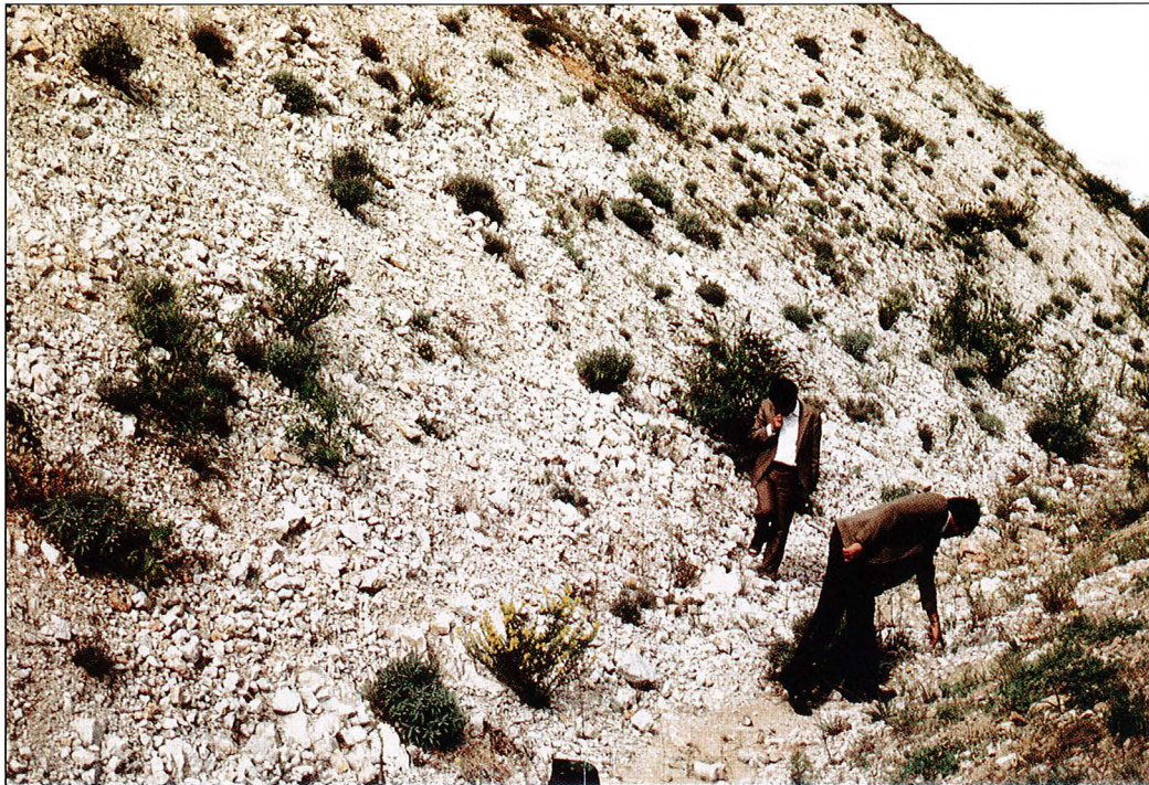
Photo n° 7 : Talus calcaire autoroutier résistant à l'érosion, dans le Midi de la France. Noter la végétation clairsemée. Quelques plantes pourront néanmoins se développer et améliorer l'esthétique du talus (qui n'est pas mauvaise).
