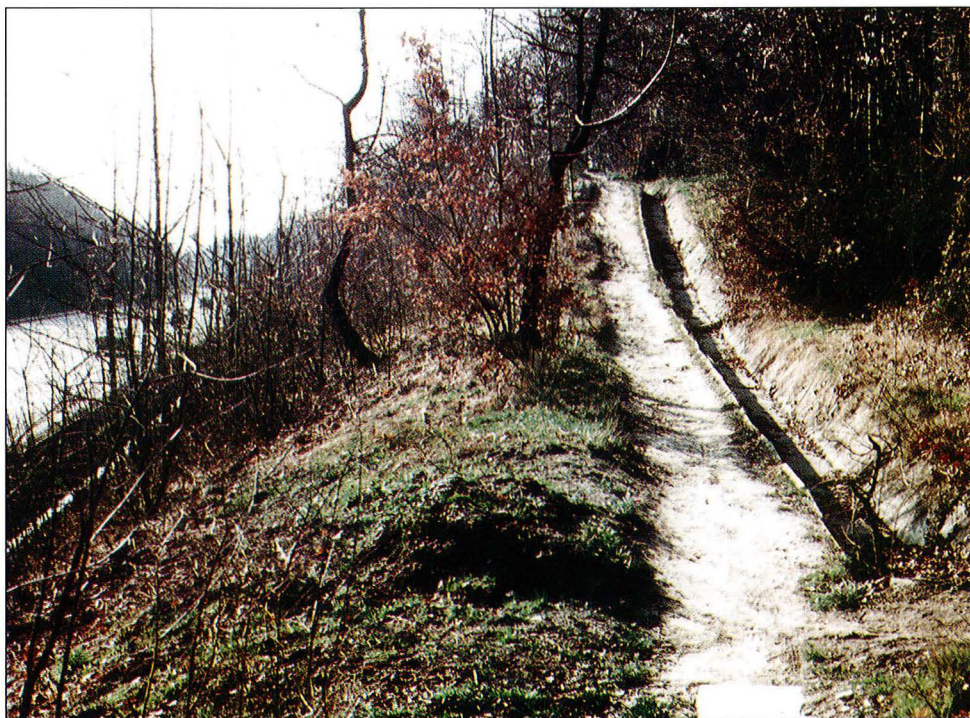
Photo n° 36 : Fossé de crête au sommet d'un déblai autoroutier.
