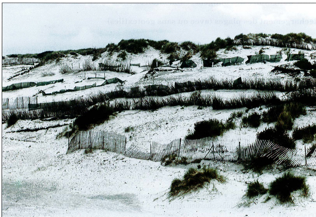
Photo n° 44 : Fixation d'une dune à l'aide de brise-vent (ganivelles, filets plastiques, branchages) et d'une fixation à terre (oyats).
