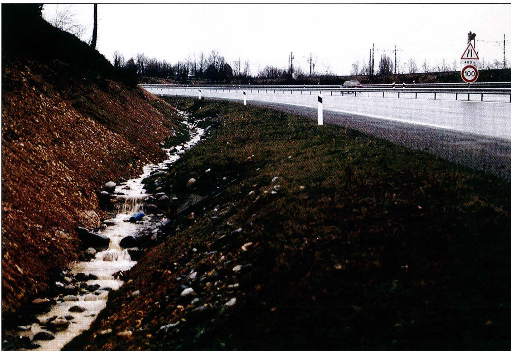
Photo n° 40 : Fossé autoroutier en sol graveleux. Un équilibre satisfaisant peut s'établir. Un meilleur engazonnement semble cependant souhaitable.
