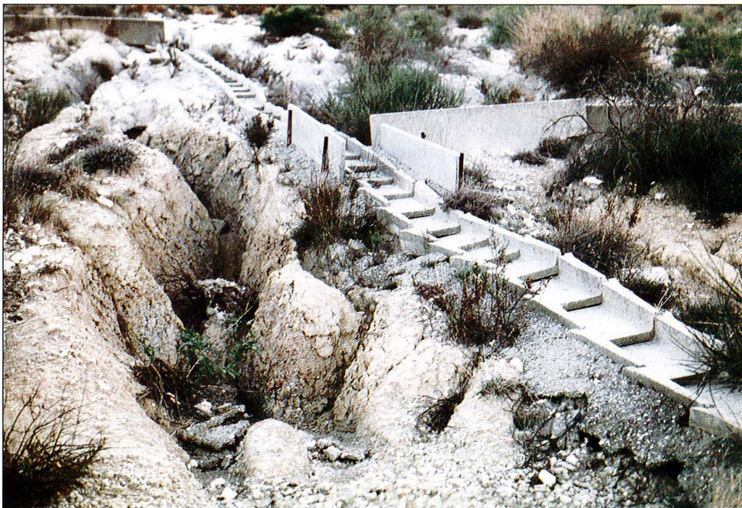
Photo n° 42 : Mauvaise conception et implantation d'un fil d'eau et de sa descente.
