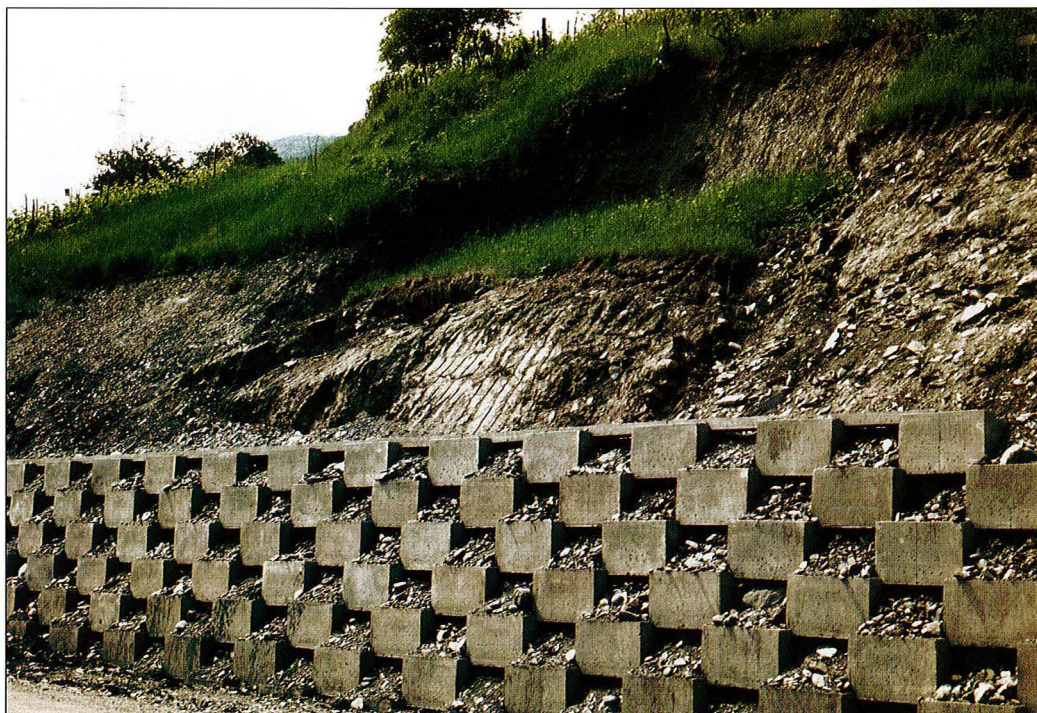
Photo n° 33 : Mur cellulaire à encoffrement.
