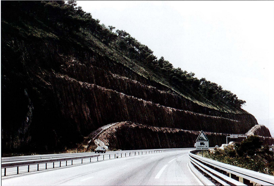
Photo n° 27 : Déblai rocheux autoroutier en marches d'escalier.
