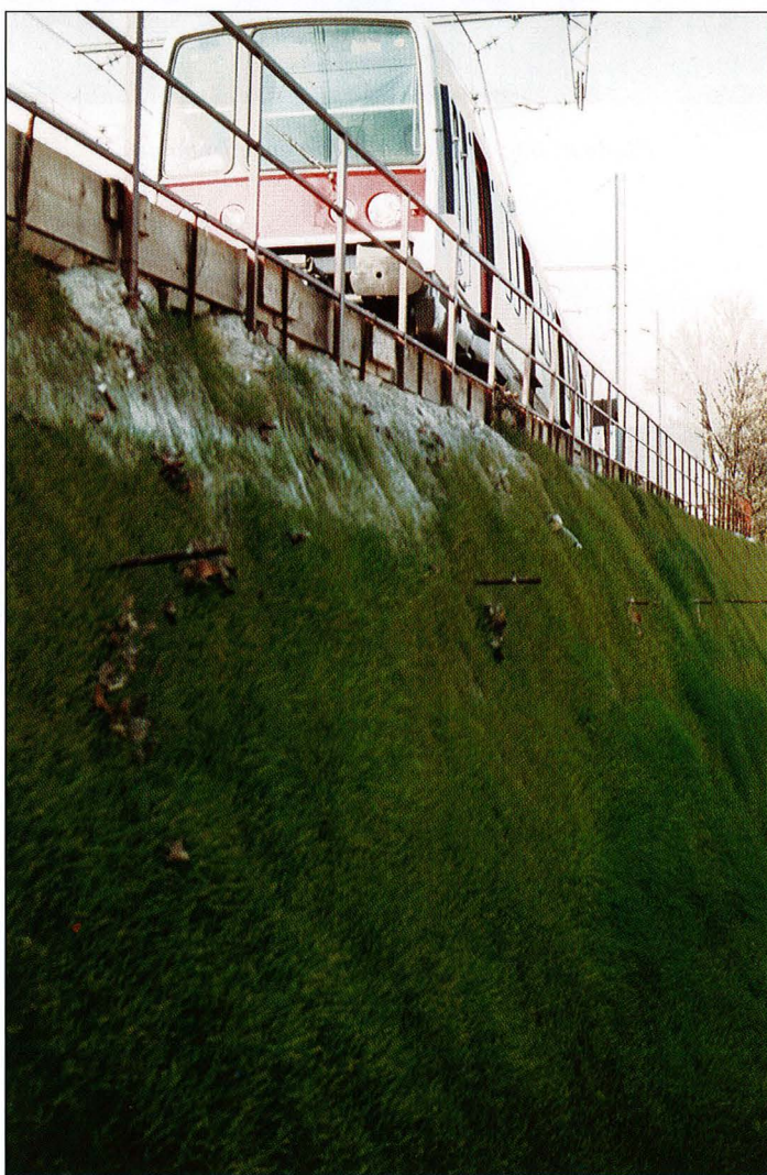
Photo n° 32 : Massif en Texsol engazonné supportant une voie ferrée.
