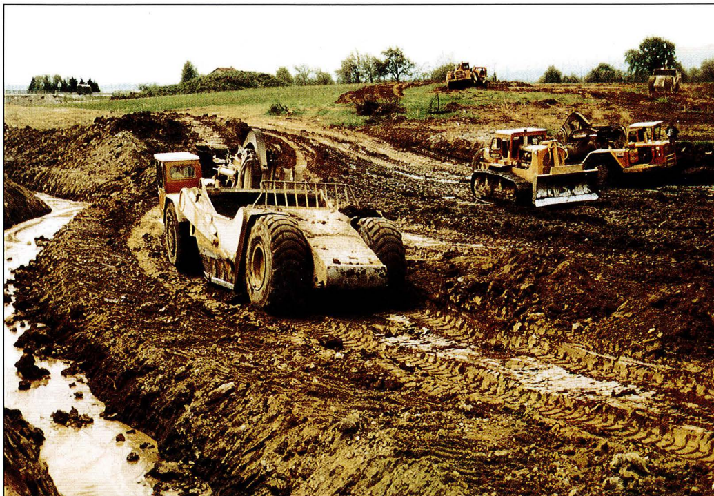
Photo n° 2 : Atelier de terrassement assaini par un large fossé drainant (Une trappe de sédimentation serait utile avant le rejet des eaux dans la rivière )
