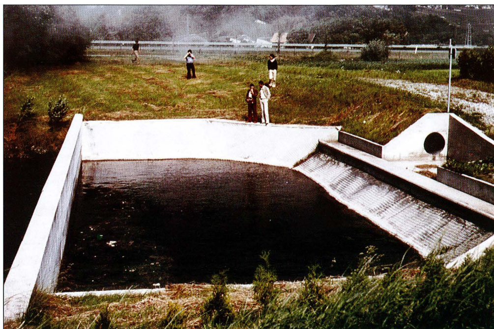
Photo n° 3 : Bassin permanent de déshuilage le long d'une autoroute, dans une zone où il faut absolument protéger la nappe phréatique
