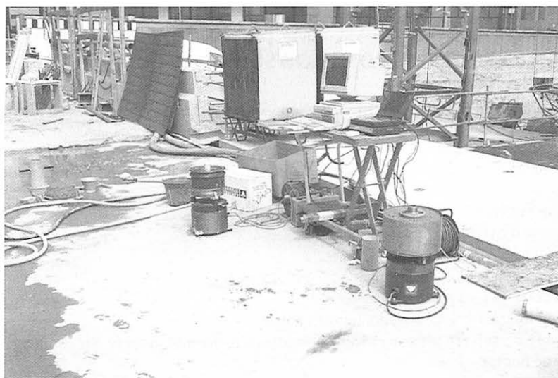
Figure VII.2 – Essais sur le béton (chantier "Cœur Défense").
