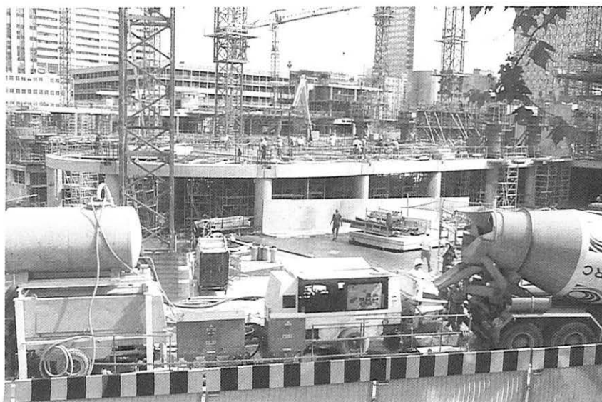
Figure VII.1 – Chantier "Cœur Défense".
