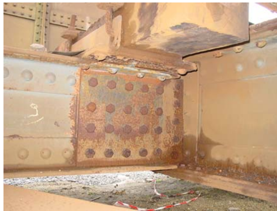
Figure 6.2. Vue d'un renforcement par triplure boulonnée
