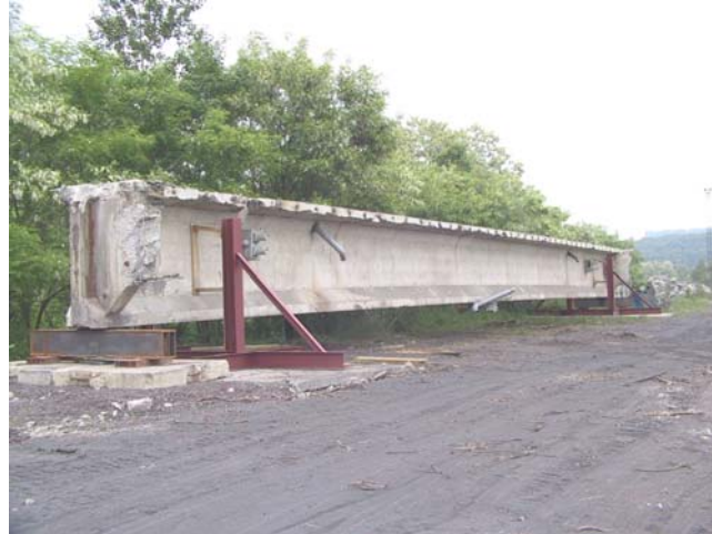
Figure 8.3. Poutre précontrainte déposée du VIPP de Merlebach
