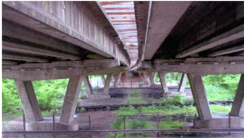
Figure 8.2. Vue générale du VIPP de Merlebach
