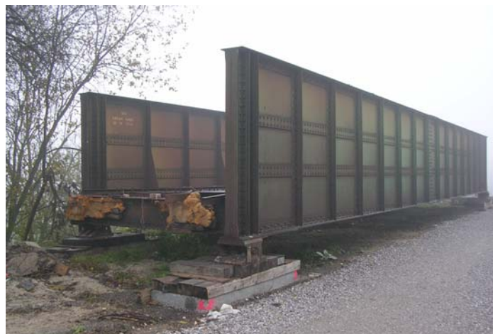
Figure 6.15. Vue générale du pont déplacé mis sur cales
