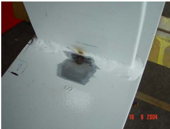
Figure 2.6. Point de soudure TIG sur le cordon de soudure
