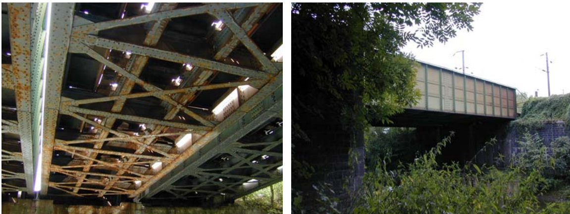
Figure 6.1. Vue générale du pont d'Avesnes
