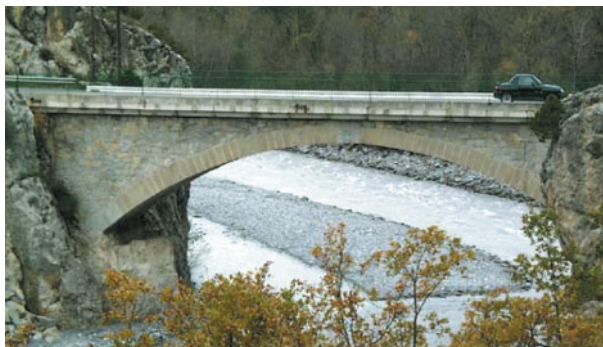
a. Vue générale de l'ouvrage.
