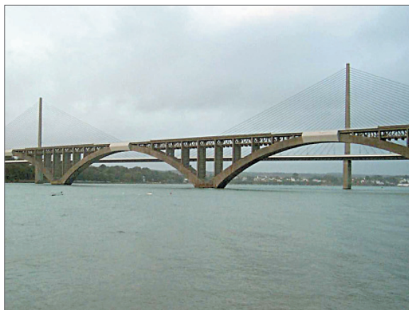
a. Vue générale de l'ouvrage.
