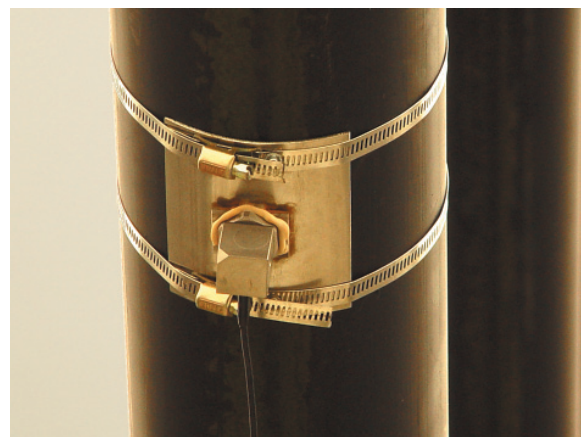
b. Accéléromètre monté sur hauban.
