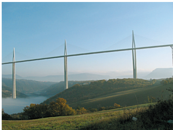
a. Vue générale de l'ouvrage.
