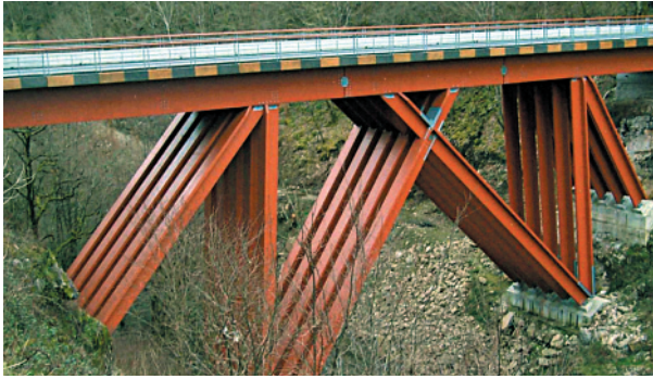
a. Vue générale de l'ouvrage.
