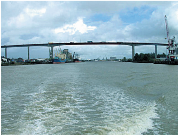
a. Vue générale de l'ouvrage.
