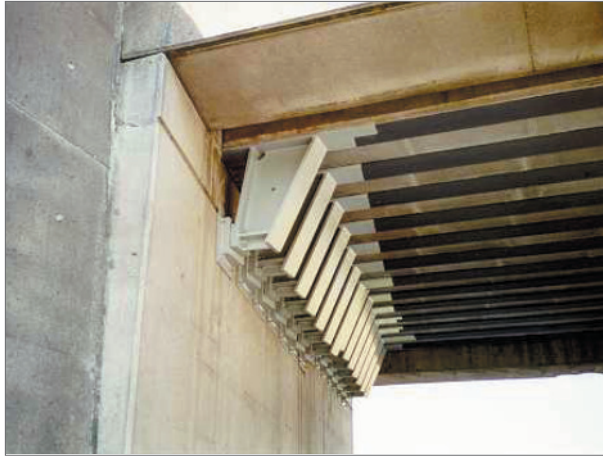
a. Bielles d'appui du pont-rail PK 075 + 317.
