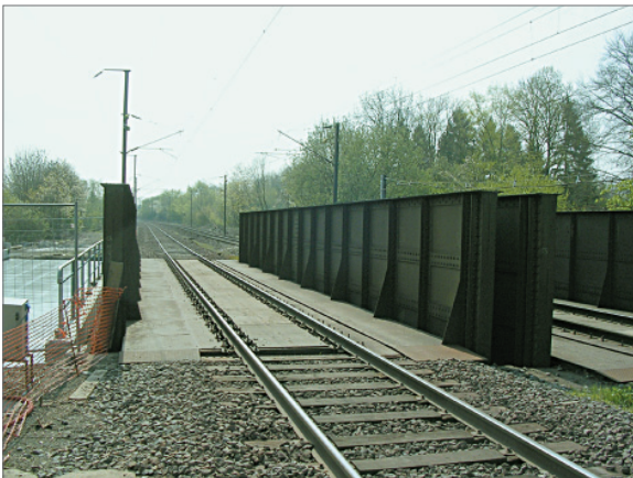
a. Vue générale de l'ouvrage.
