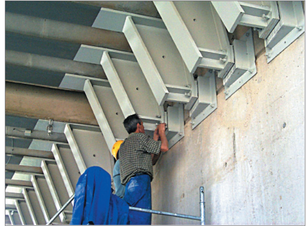
b. Resserrage des bielles d'appuis par clé dynamométrique.
