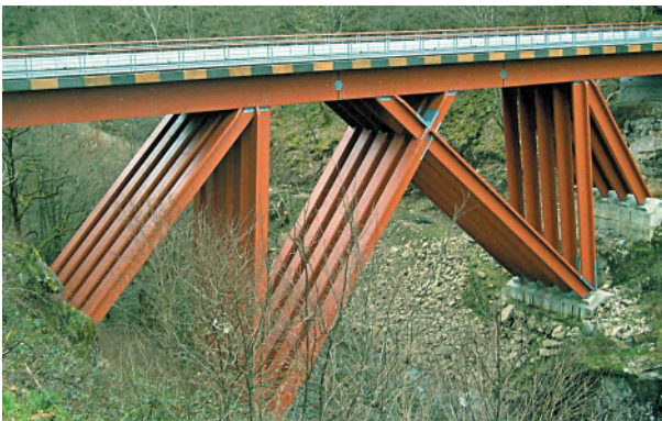
a. Vue générale de l'ouvrage.
